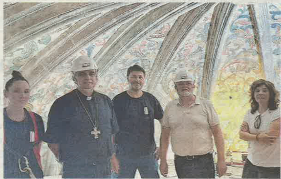
Las autoridades y técnicos de las obras bajo el ábside de la Catedral. / JCCM
