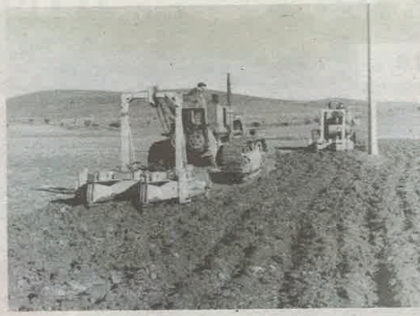
Labor de desfonde en el Parque de Maquinaria. / MINISTERIO DE AGRICULTURA
