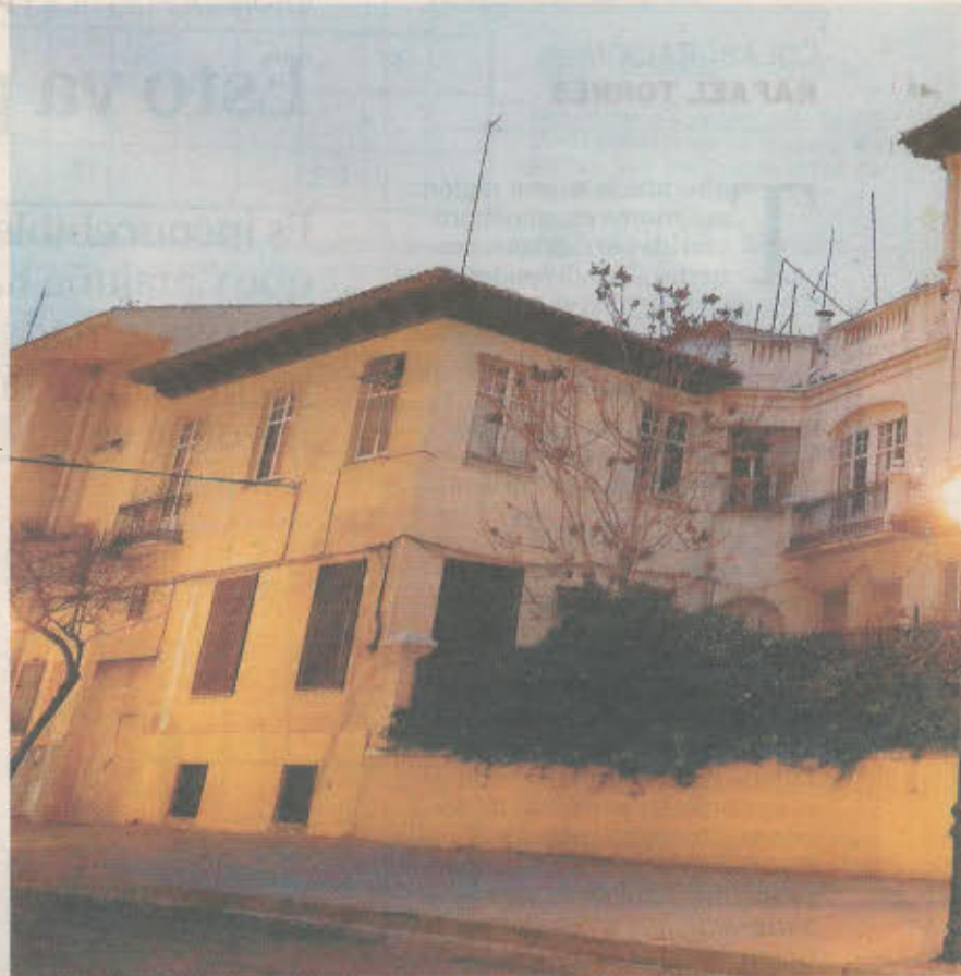
Estado actual del exterior del edificio del Paseo Simón Abril. / R. SERRALLÉ
