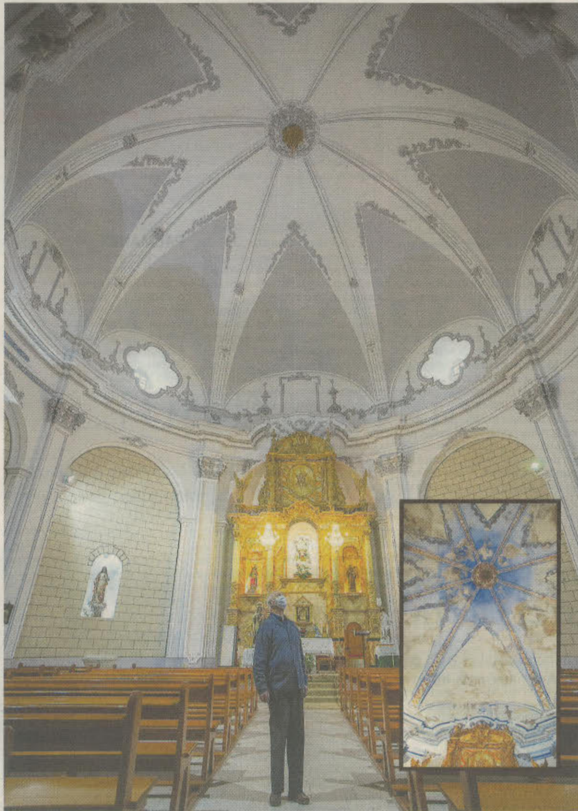
Aspecto actual de la cúpula, tras la restauración, junto al deteriorado que tenía anteriormente. / RUBÉN SERRALLÉ / C.B. (AYTO.)
