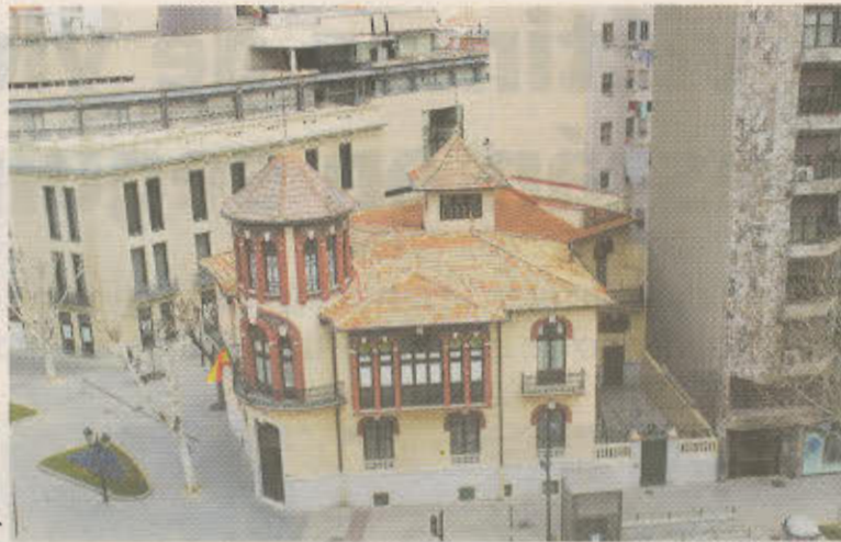
Imagen actual del edificio que alberga la Subdelegación de Defensa. / DEFENSA
