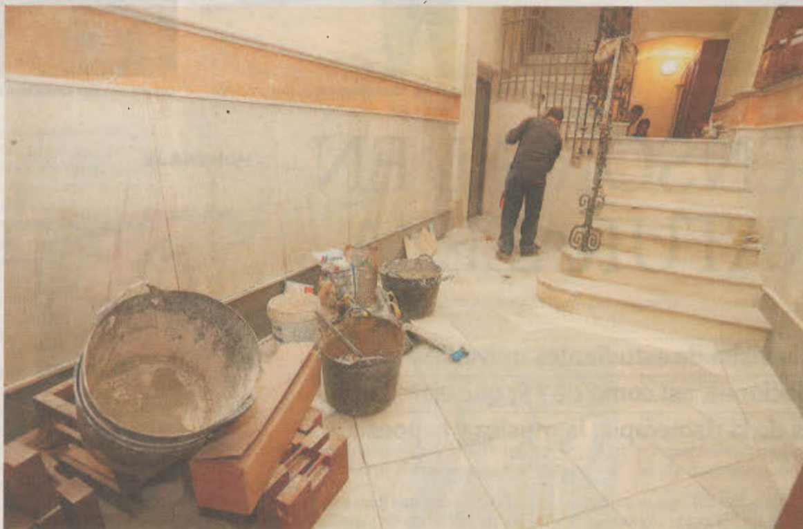
Un trabajador de una empresa de la construcción, en las obras de un portal. // JOSÉ MIGUEL ESPARCIA
