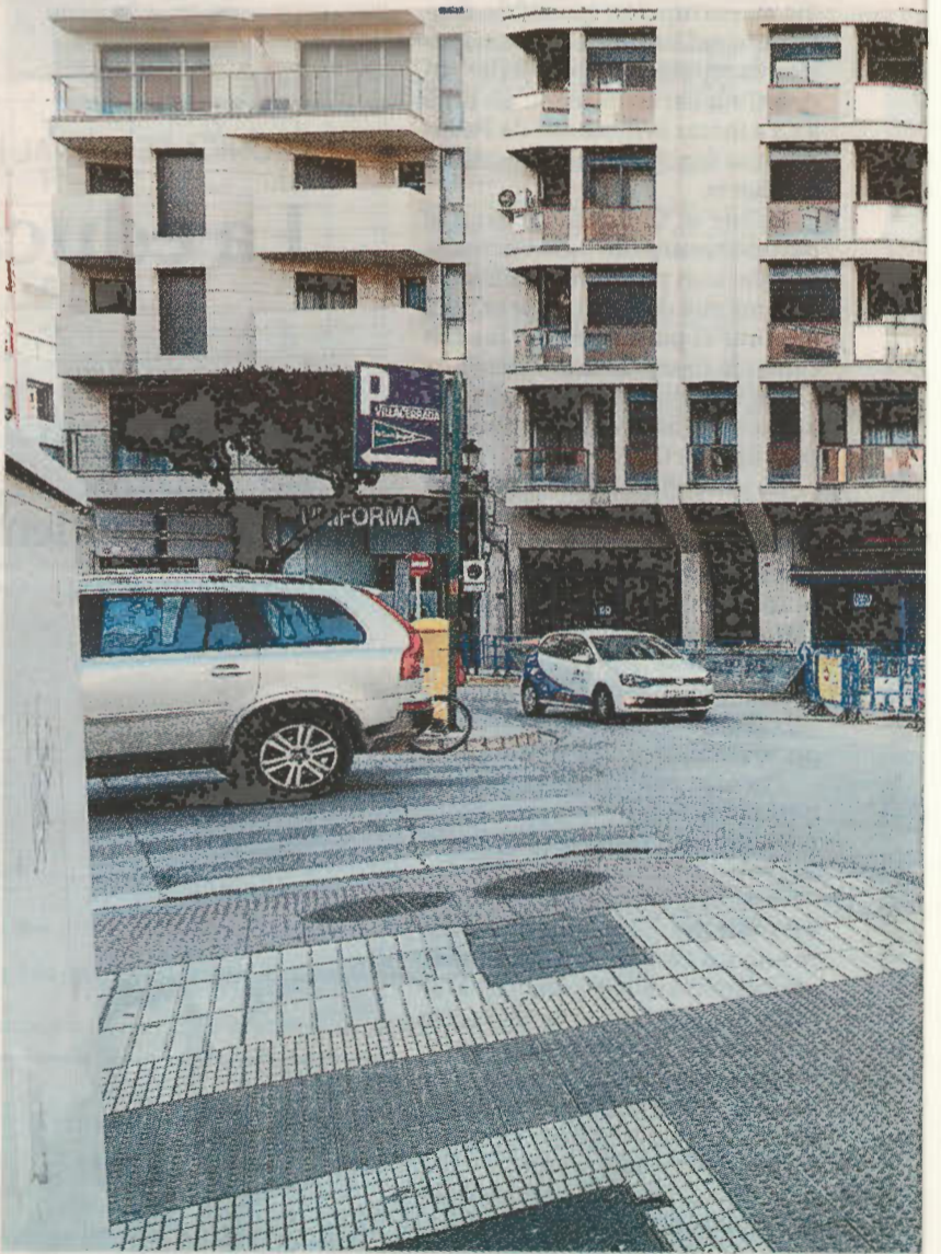
Las obras de Aguas de Albacete en la zona de Albarderos ya están en marcha. / A. PÉREZ
