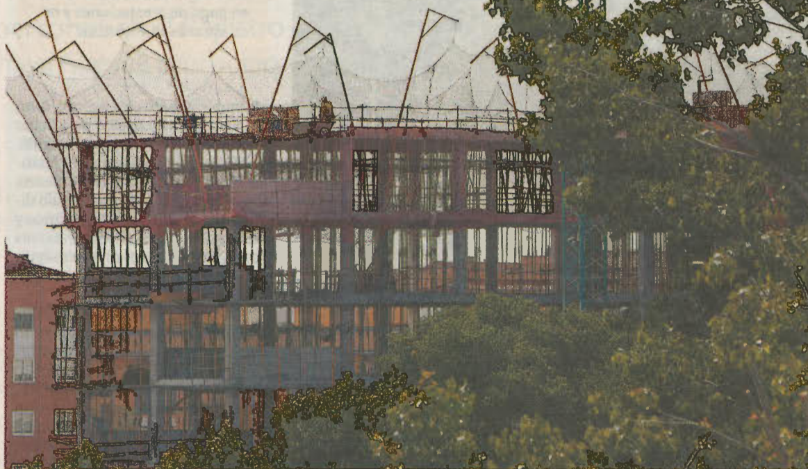
Uno de los bloques de viviendas que se construye actualmente en la zona del Paseo de la Cuba. / RUBÉN SERRALLÉ
