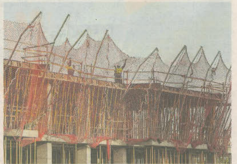
Imagen de una obra de la ciudad. / RUBÉN SERRALLÉ
