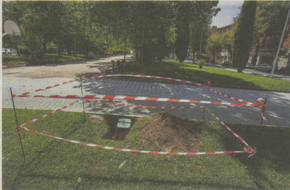
Los últimos trabajos para mejorar el sistema de riego se realizan en el Parque Lineal. / JOSÉ MIGUEL ESPARCIA
