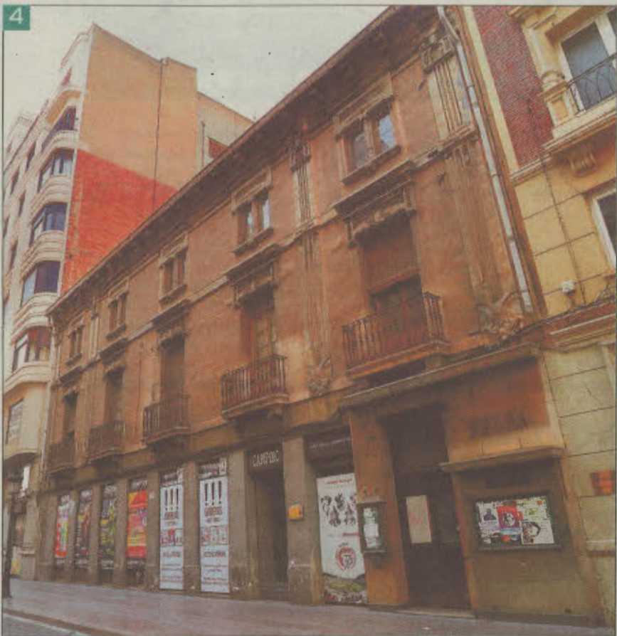
1. Restos del Puente de Madera, junto a la calle Alcalde Conangla. 2. La polémica sobre la necesidad de actualizar el Catálogo de Edificios Protegidos surgió con las rejas en un inmueble de la calle Ancha. 3. El antiguo Silo que quedará ahora también bajo la figura de protección. 4. Edificio en la calle Marqués de Molins que también será catalogado como protegido. / ARTURO PÉREZ
