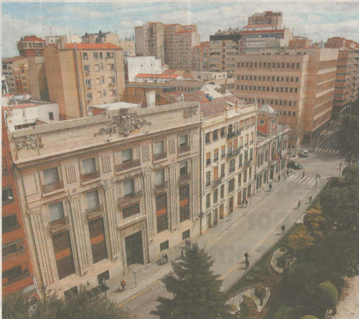
La monumentalidad del edificio del Banco de España impone en la plaza del Altozano. / RUBÉN SERRALLÉ
