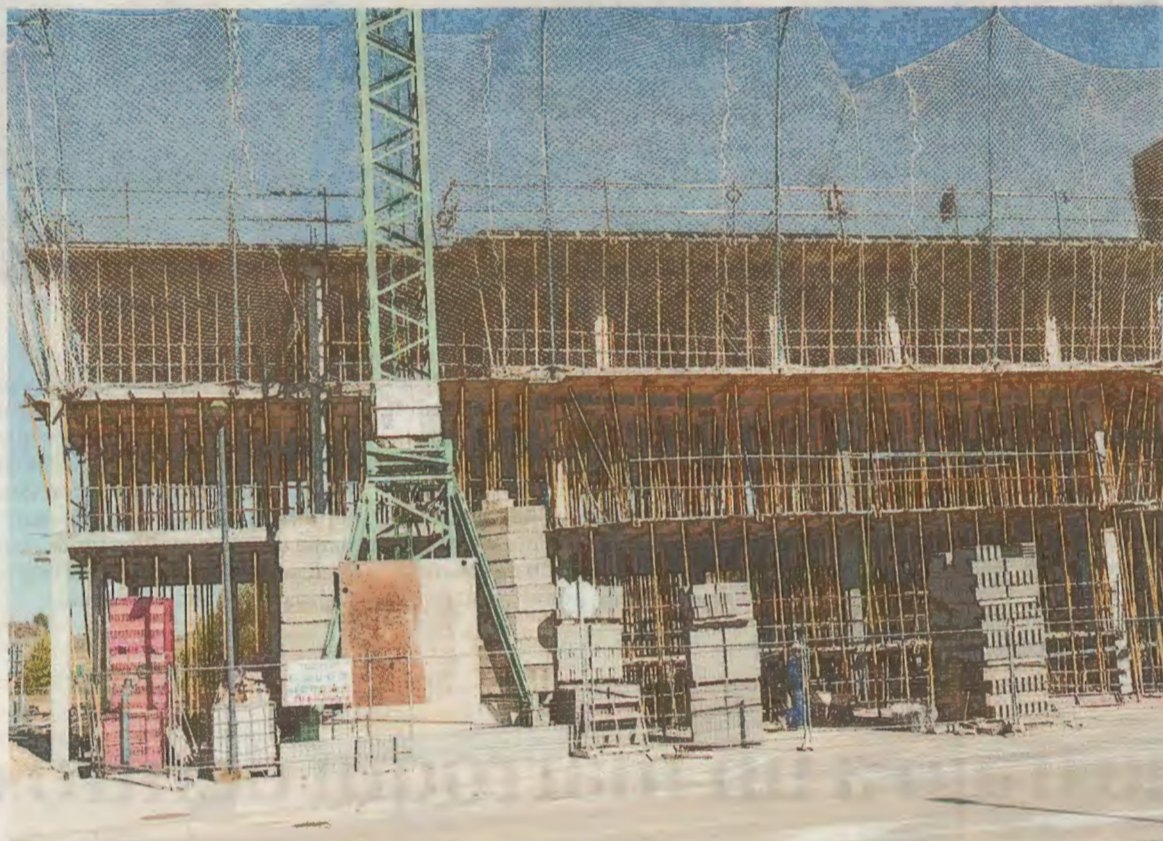
Edificio en construcción destinado a viviendas. / P.G.
