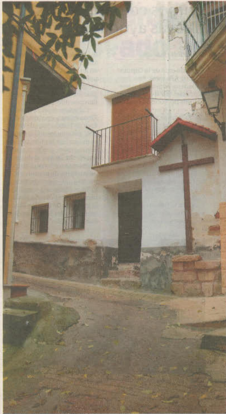
El antiguo callejón de la Cruz Verde en Alcaraz (hoy calle Bracamonte). / E.V.
