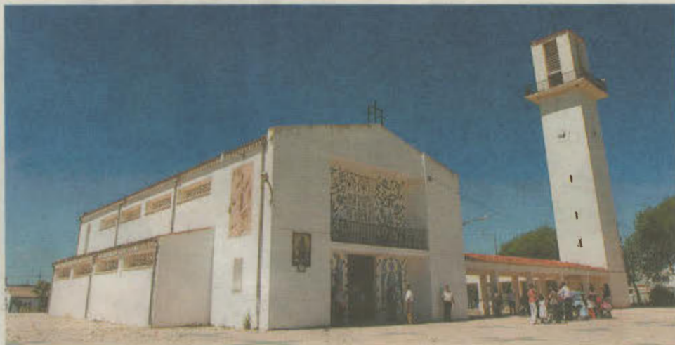
Las aguas del Pasico dieron lugar a la proyección y al levantamiento de Aguas Nuevas. / C.L.
