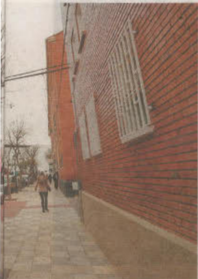
Las viviendas conocidas como las grilleras también se incluirán en el ARRU para mejorar la eficiencia energética y la accesibilidad. Se pretende modificar el PGOU para incrementar la altura de las edificaciones.
