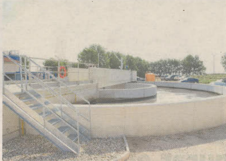
Instalaciones de la EDAR de Pozo Cañada. / JCCM
