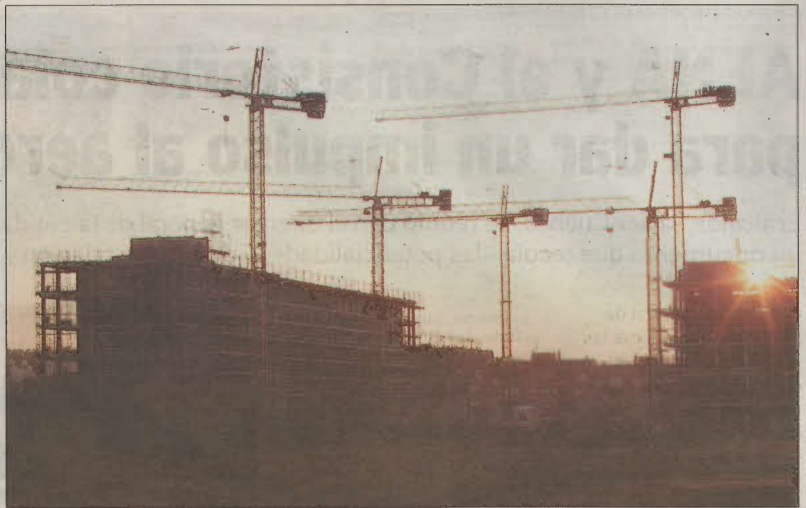
La construcción de nuevas promociones de viviendas se empieza a ver en los municipios de la provincia. / Y.R.
