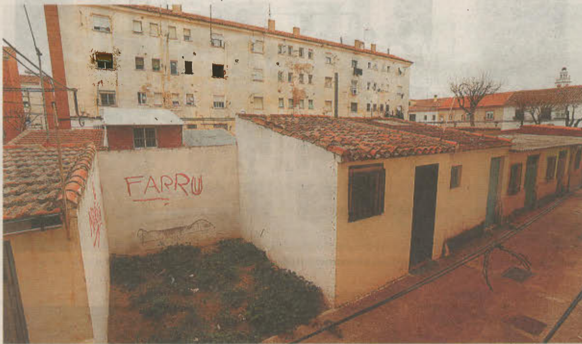
El espacio entre patios de las Grilleras se usará para colocar la caja del ascensor y hacer un 'parking' subterráneo. / ARTURO PÉREZ
