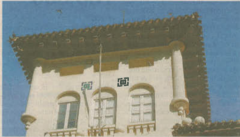
Detalle del edificio a rehabilitar para dar un uso administrativo. /J.M.E.
