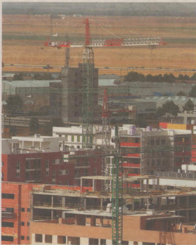
Grúas sobre edificios residenciales en construcción en la capital. / R.S.
