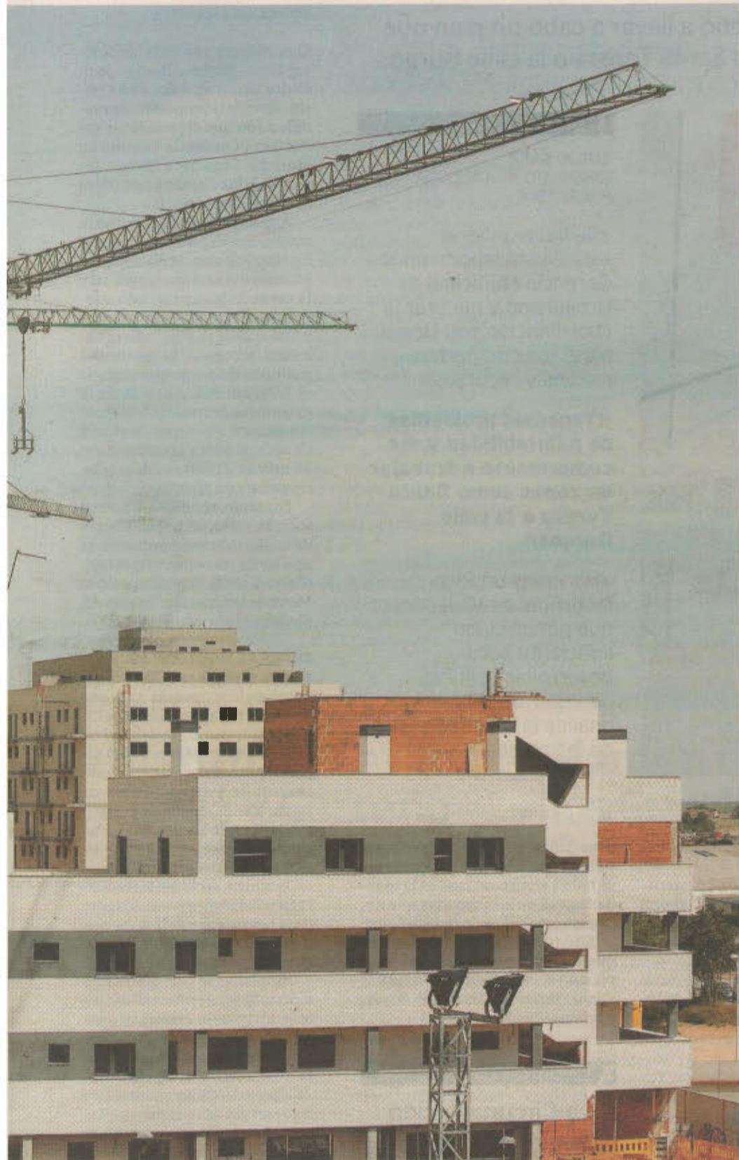
Las grúas que se observan por la ciudad muestran las obras de nueva planta. / R. S.
