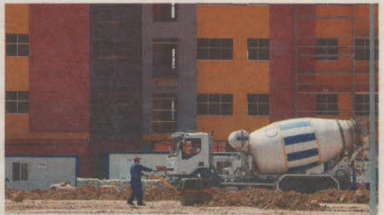
Obras en marcha en un edificio de viviendas. / D.A.
