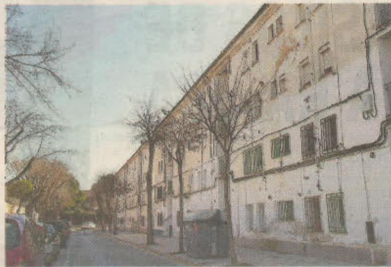
Calle Burgos, una de las vías que espera la rehabilitación. / J.M. ESPARCIA
