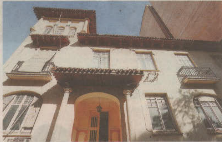
Acceso principal al antiguo edificio policial objeto de la reforma. // J.M. ESPARCIA
