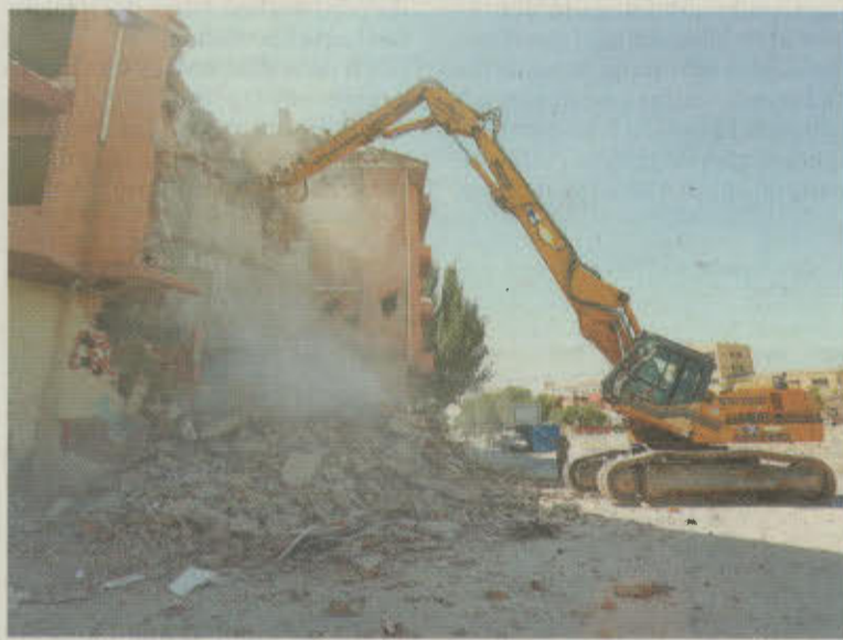
Trabajos de demolición de Las 600 de años anteriores. / ARTURO PÉREZ
