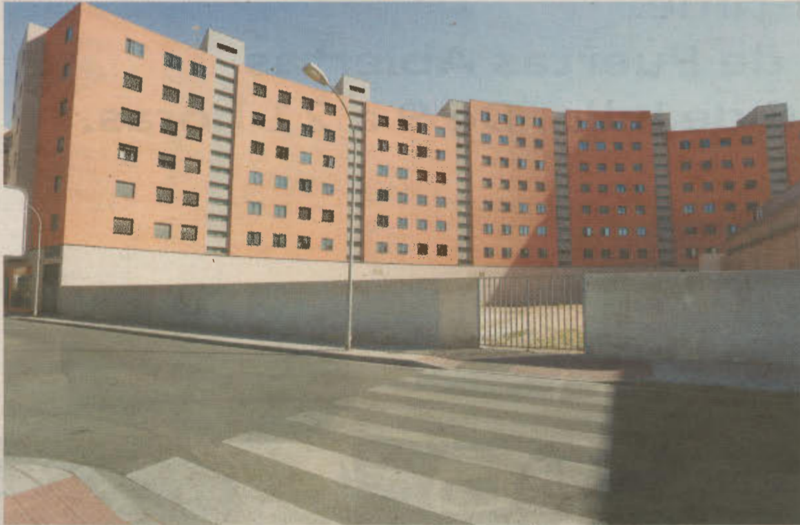
Solar de la calle Lepanto en el que se ubicará un nuevo centro de participación ciudadana y de mayores. / R. SERRALLÉ
