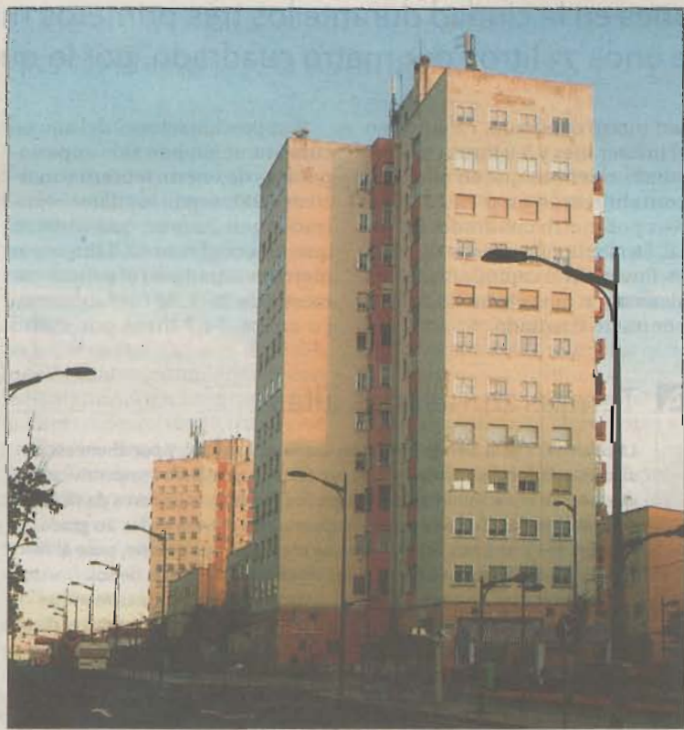
Edificación de Las 500 viviendas, junto al Hospital General. / RUBÉN SERRALLÉ
