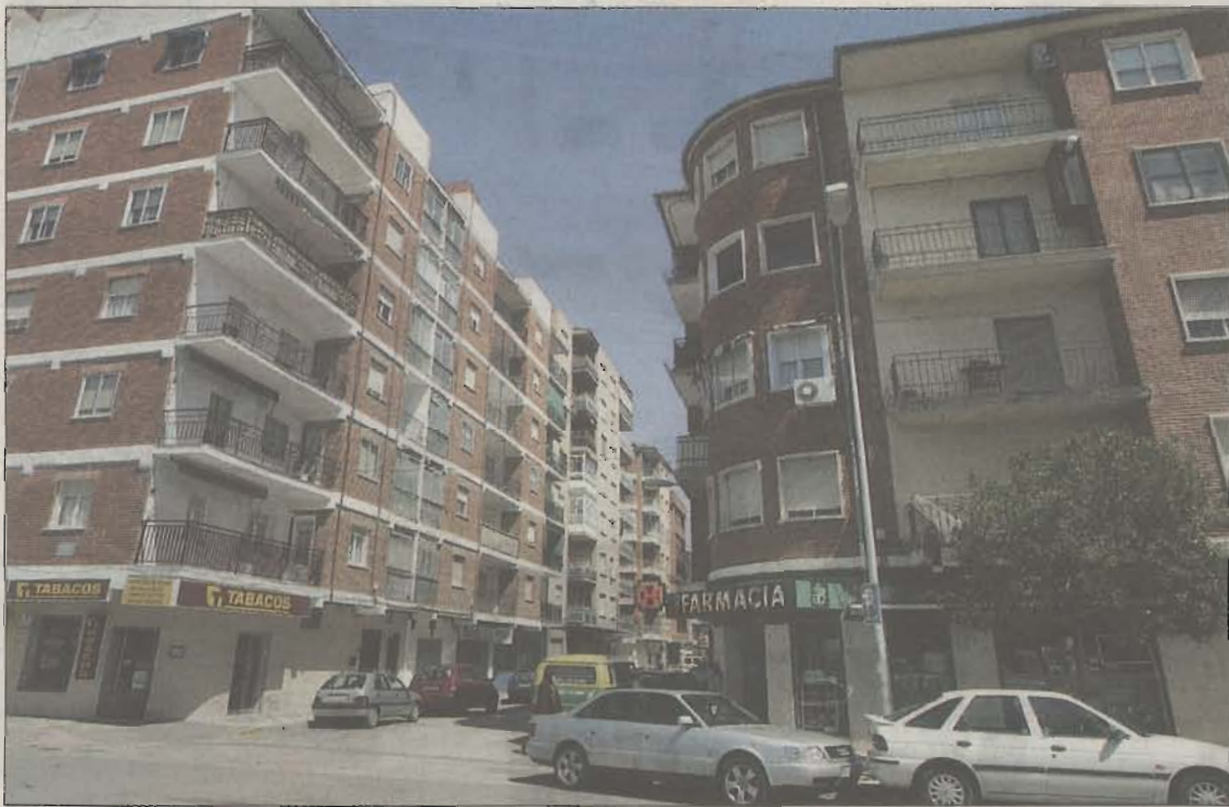
Bloques de pisos en el barrio del Ensanche, donde se encuentran edificaciones afectadas por las ITE. / ARTURO PÉREZ
