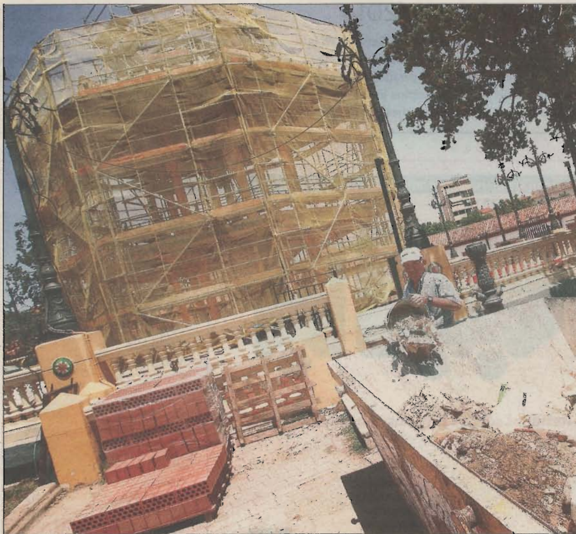
Imagen del templete en el interior del recinto en los meses e los que fue objeto de remodelación. / RUBÉN SERRALLE
