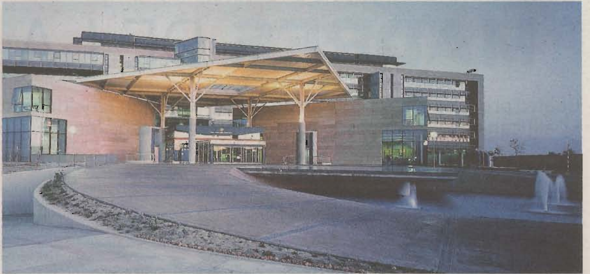
Aspecto monumental de la Euroagencia de Marcas y Patentes, en Alicante, diseñada por Escario. / CEDIDA POR J. DOMÍNGUEZ
